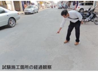
試験施工箇所の経過観察
