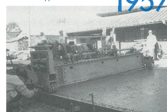
Строительство с бетоноукладчиком.
