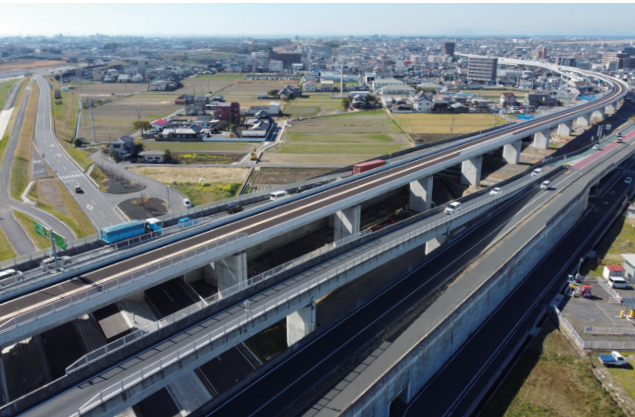
株式会社爱龟 外环机场线余户南地区铺装(第一期)工程(2024年)
