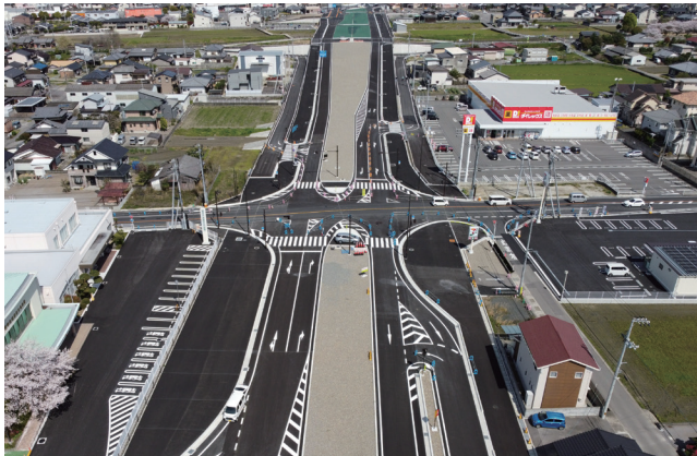
株式会社爱龟 新居滨BP中村松木地区铺装工程(2024年)
