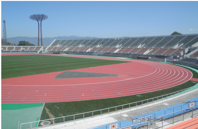
株式会社爱龟 爱媛县综合运动公园改造工程(2015年)
