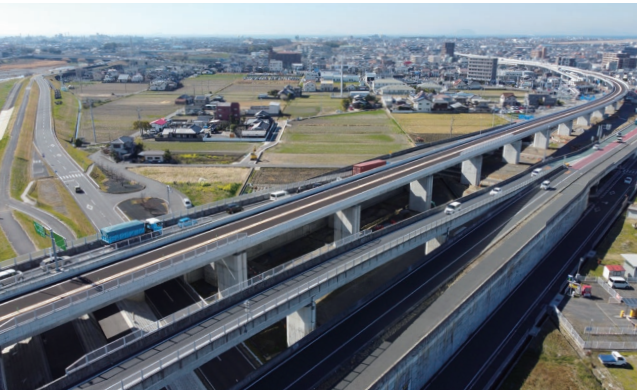
IKEE Ltd., Работы по укладке дорожного покрытия внешней кольцевой линии аэропорта на участке Йогоминами (часть 1) (2024 г.)
