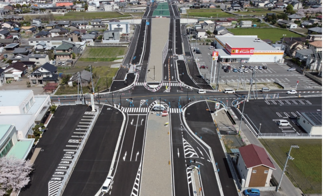
IKEE Ltd., Работы по укладке дорожного покрытия обьездной дороги Ниихама, район Накамура Мацуки (2024 г.)
