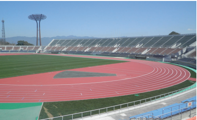
IKEE Ltd., Работы по реконструкции Главного спортивного парка префектуры Эхиме (2015 г.)
