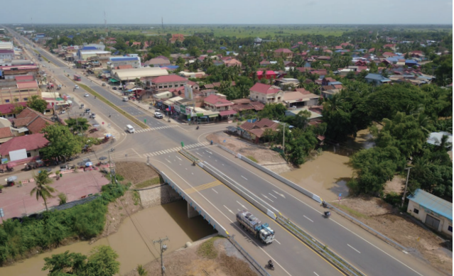
IKEE Ltd., Ремонт национальной автомагистрали №5 (участок Thlea Ma'am - Battambang CP 3 (2023 г.)
