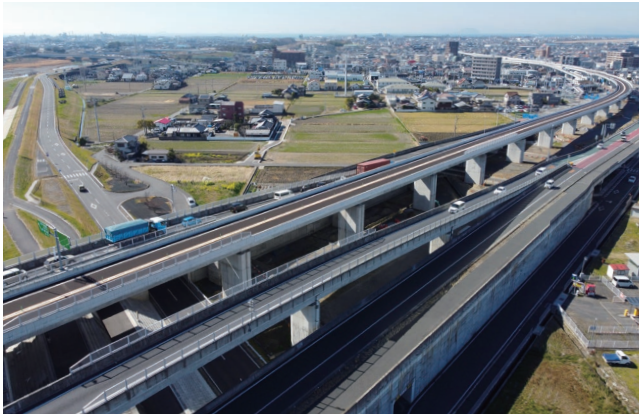
주식회사 아이키 외환상선 공항선 요도미나미지구포장 (그1) 공사 (2024년)
