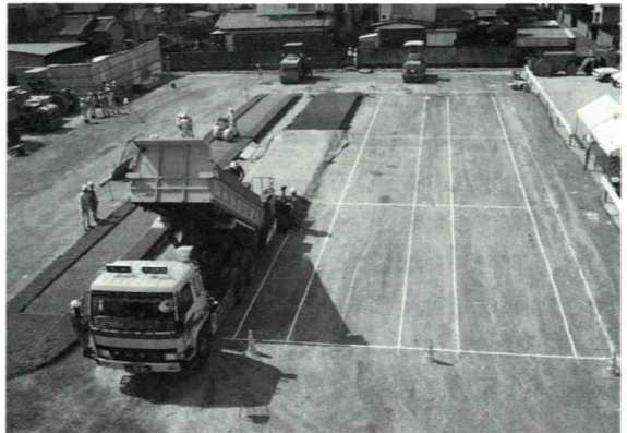
写真-1 粒調路盤材料の敷きならし
