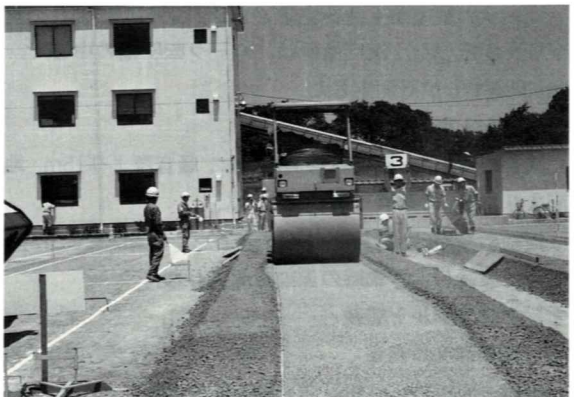
写真-2 振動ローラによる転圧
